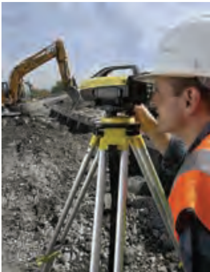
شکل ۱- ۱۴ اجرای تسطیح و کنترل حین اجرا
