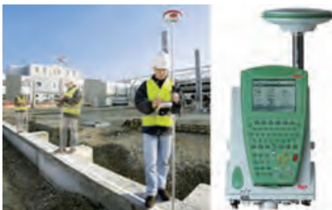
شکل ۷-۶ - پیاده کردن نقاط با GPS و PDA
